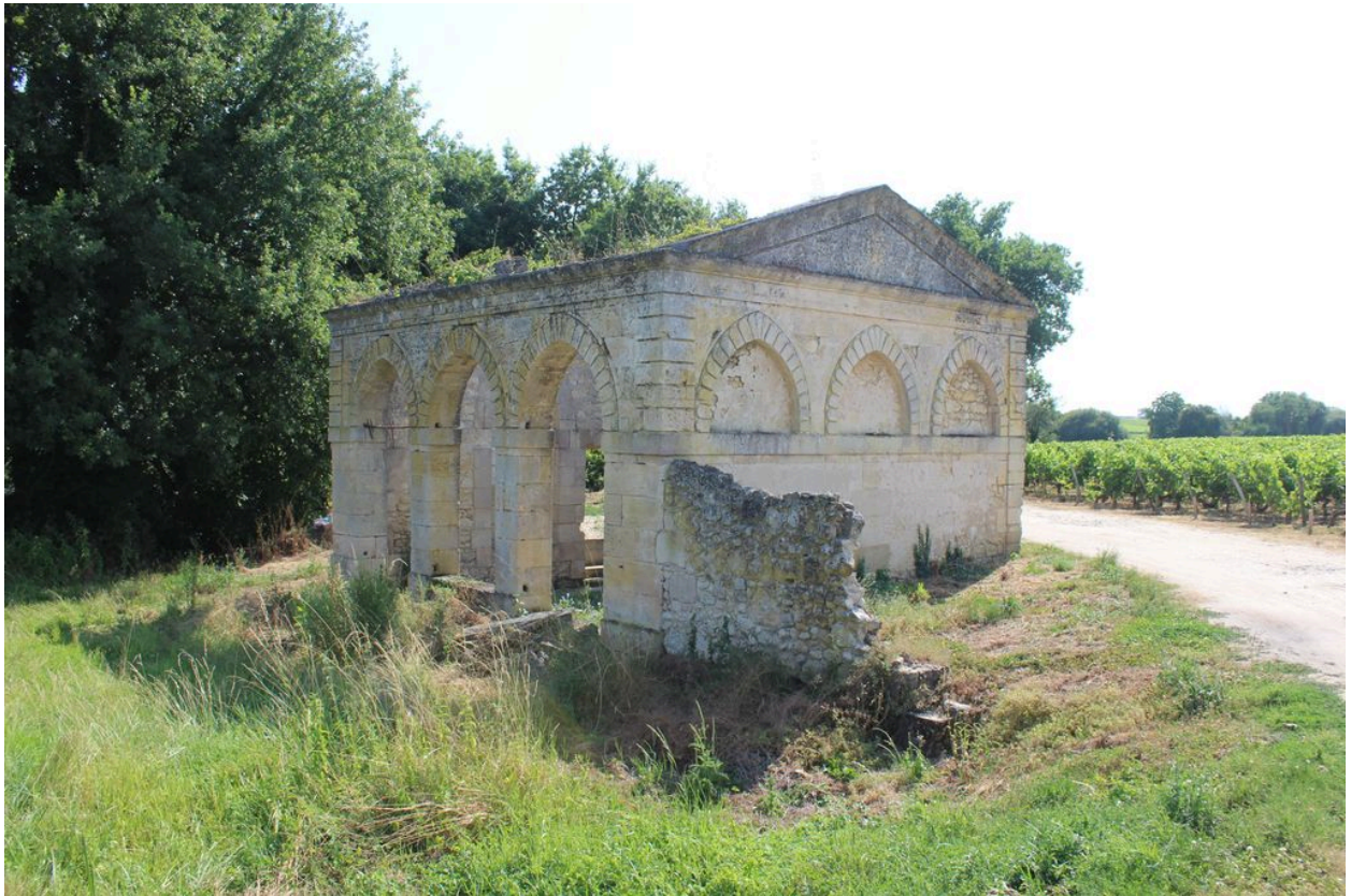
Façade est et pignon nord.
