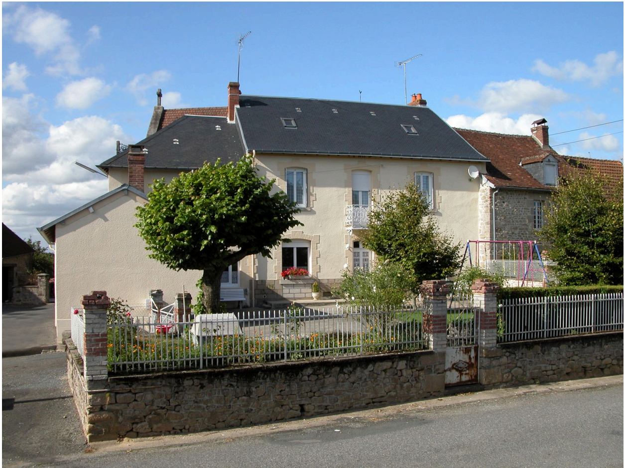
L'ancienne boucherie, près de l'église.
