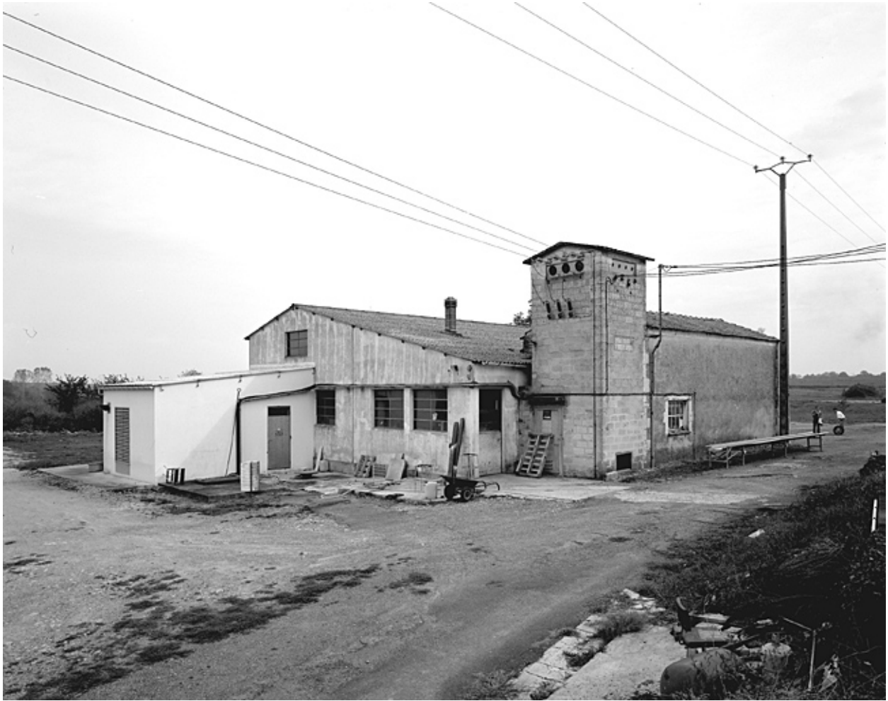
Atelier d'entretien et transformateur vus du nord ouest.
