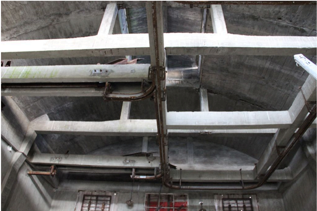
Vue intérieure : charpente et voûte en berceau en béton.
