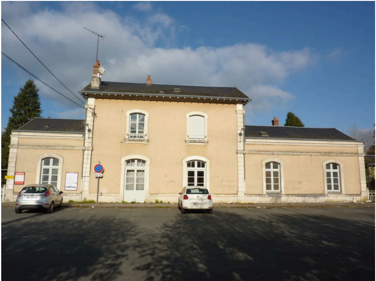
Gare, élévation sud (côté cour des voyageurs).
