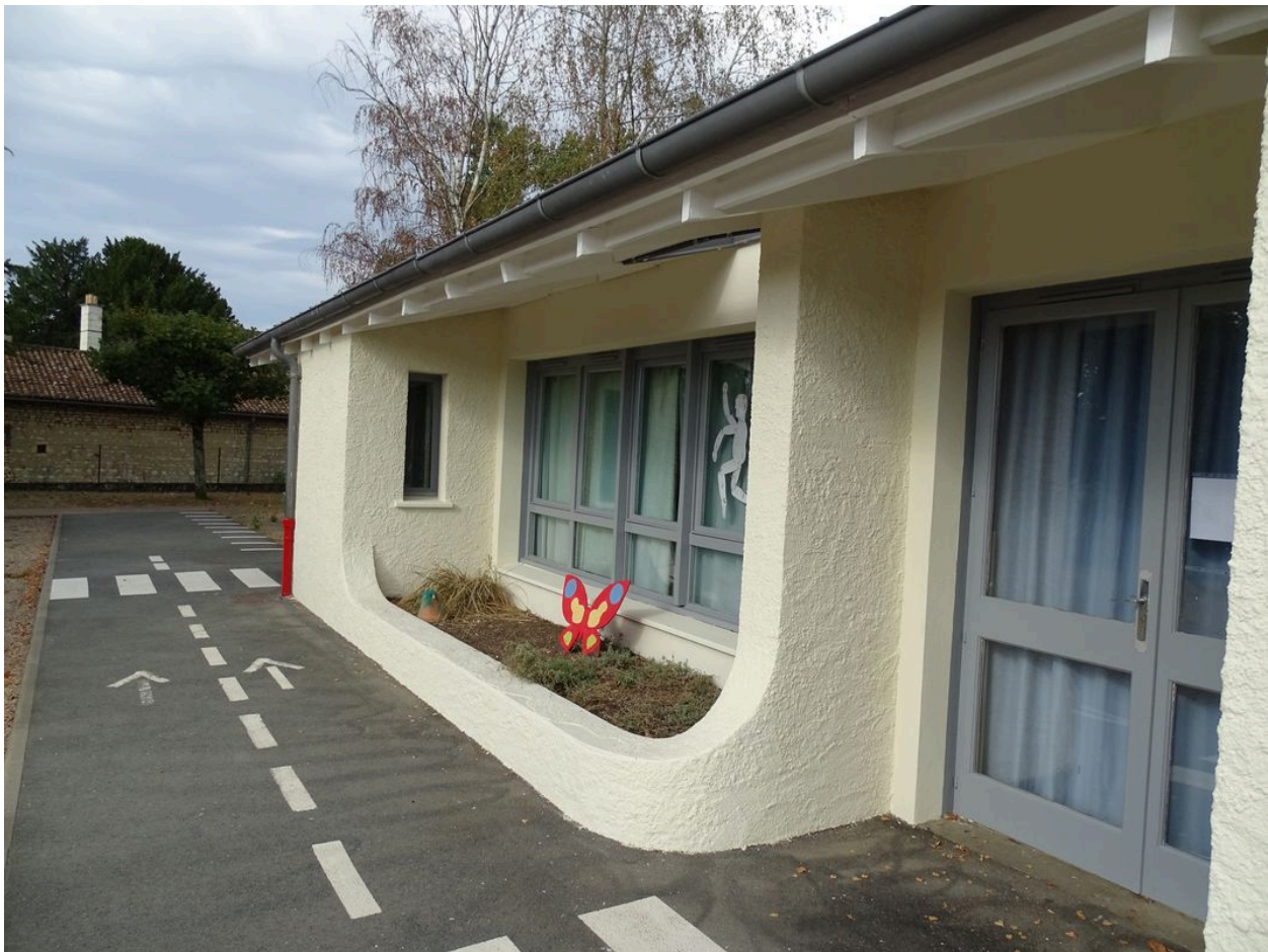
Détail d'une porte et d'une fenêtre.
