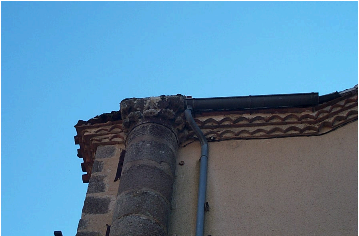
Colonne et chapiteau en remploi dans la façade de l'ancienne école de garçons.
