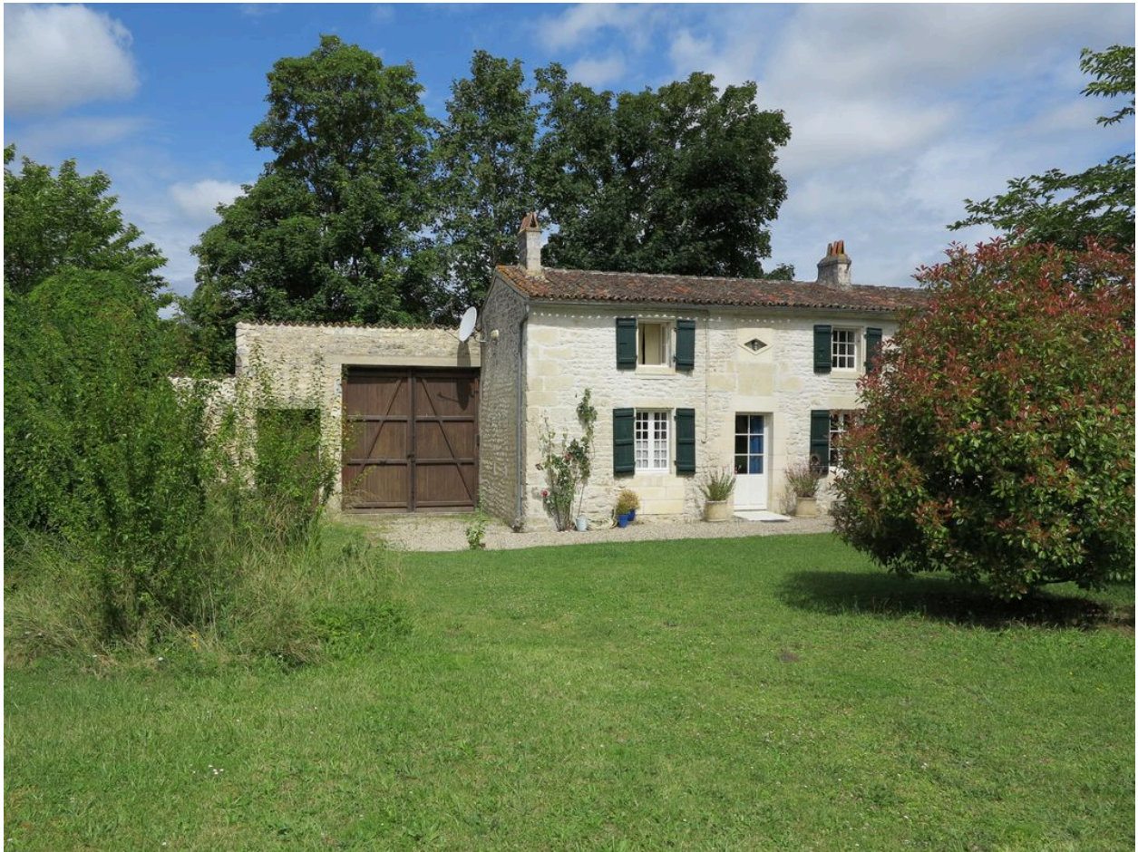
Logement de ferme (ancienne maison du métayer ?) et portail d'entrée vus de l'est.
