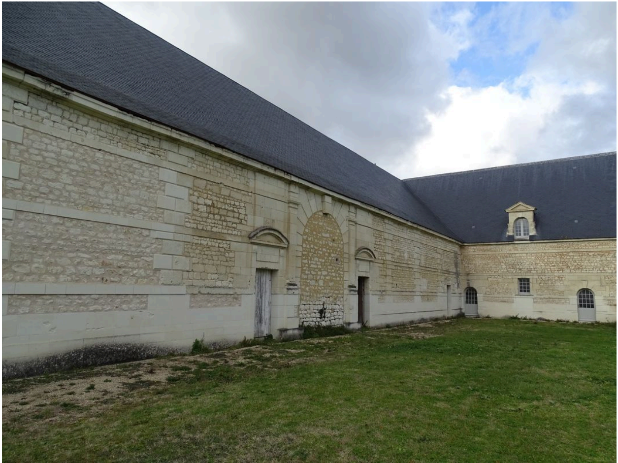
Aile ouest des communs : porte murée entourée de deux portes piétonnes.
