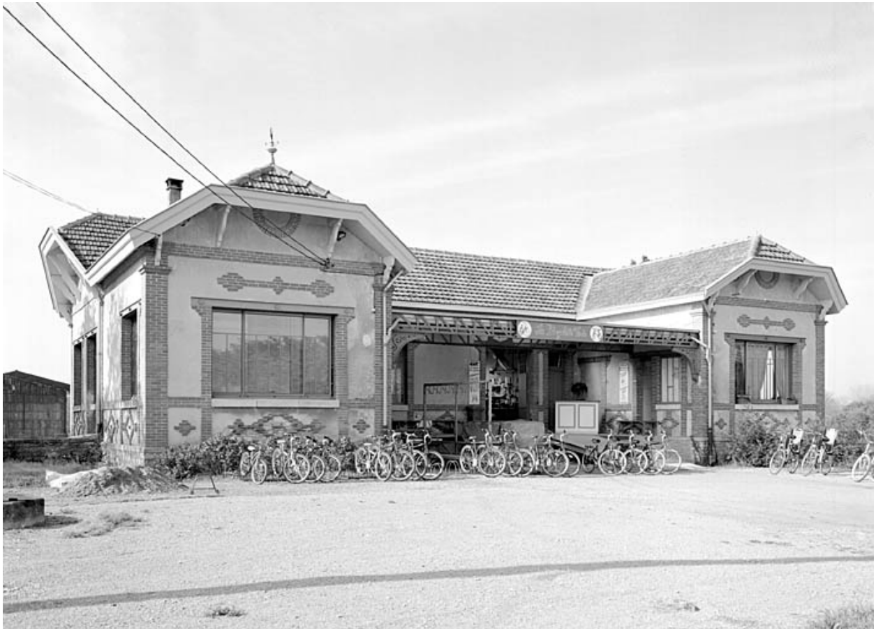
Elévation antérieure vue du nord-est.
