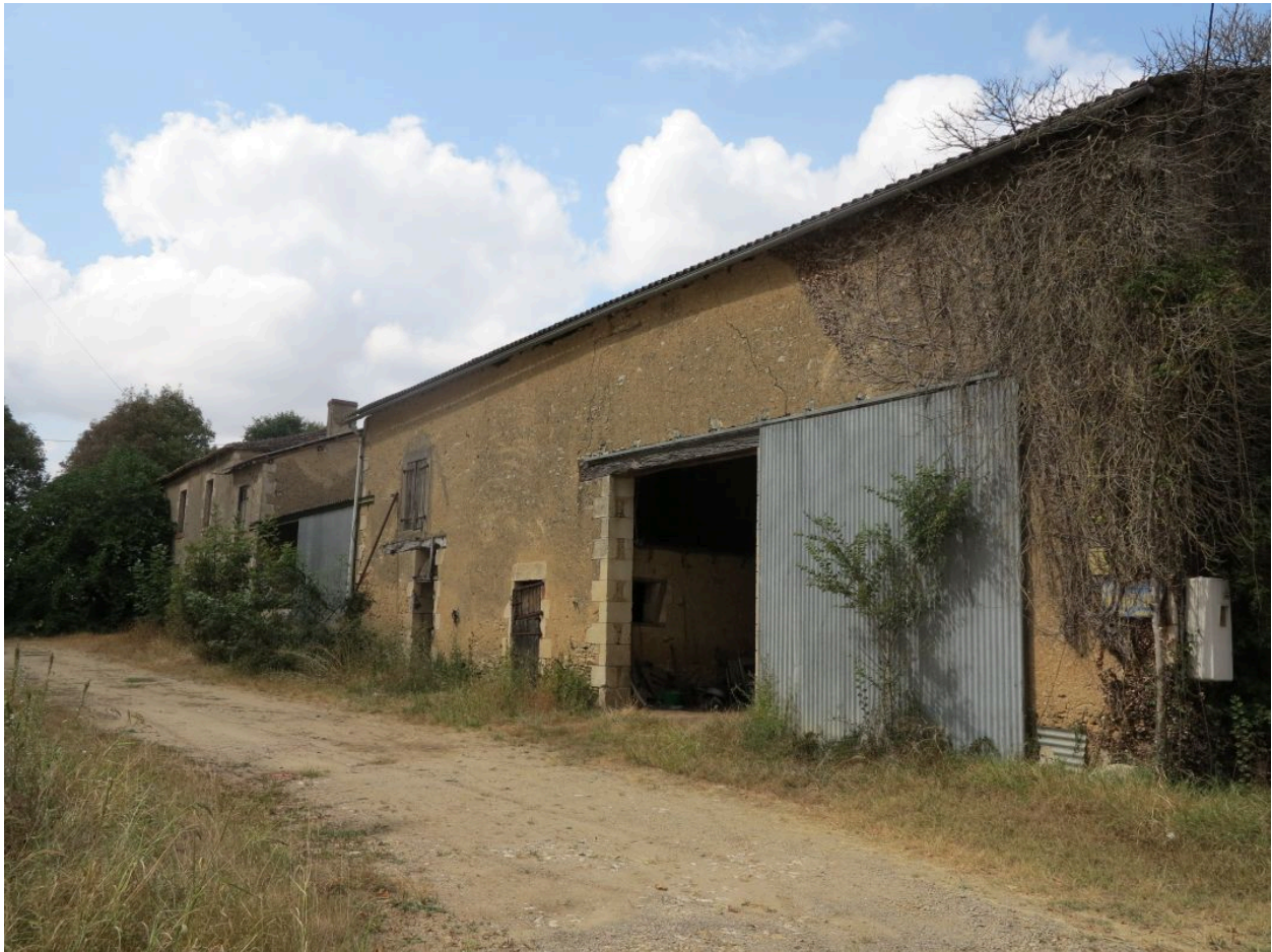
Bâtiments alignés au nord de la cour, façades sud.
