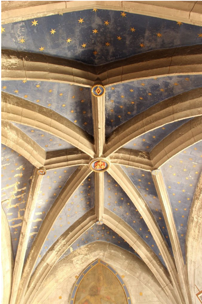
Voûte de la deuxième travée.
