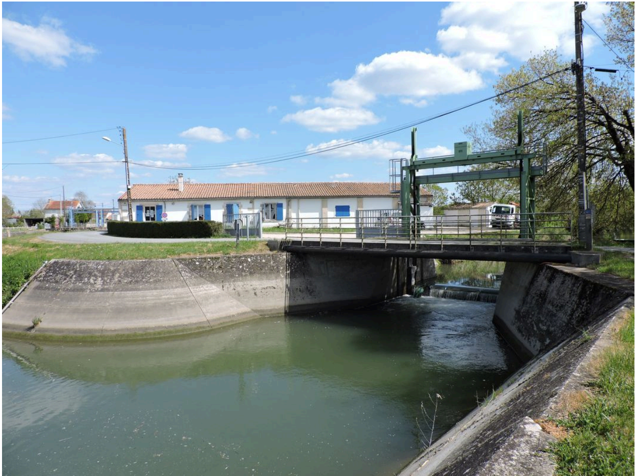
Le barrage du Vieux Bézou vu depuis l'aval, au nord-ouest.
