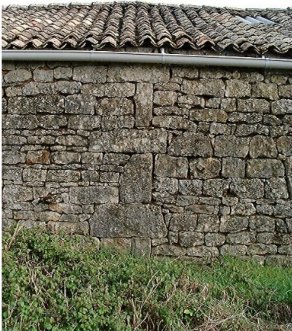
Elévation postérieure de la dépendance accolée à la grange, chaînage.
