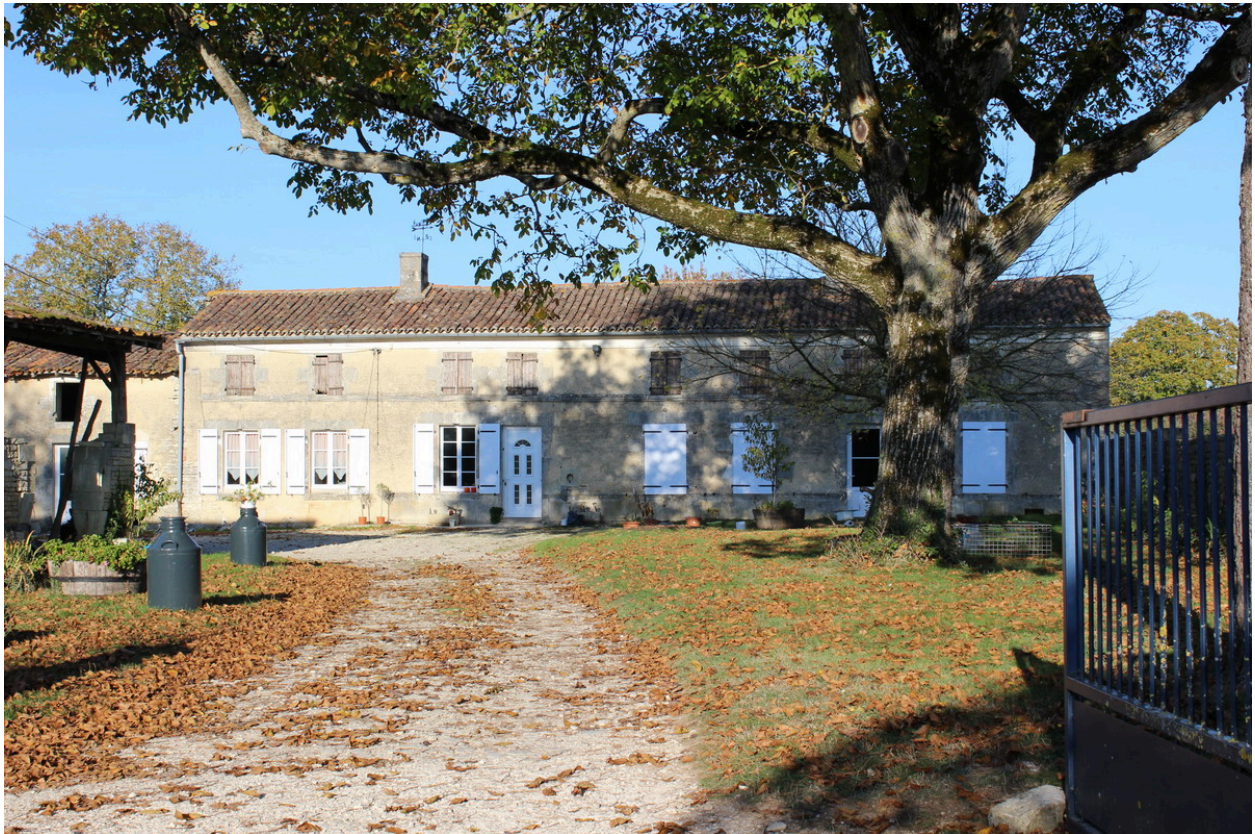
Le corps principal de l'ancienne ferme, depuis le sud-ouest.
