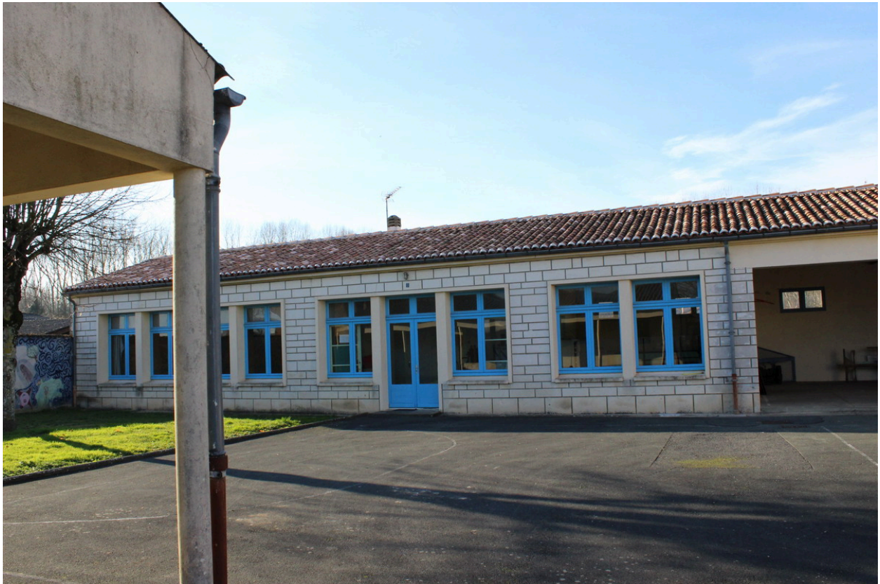
Le bâtiment dans le prolongement des préaux, depuis le nord-est.
