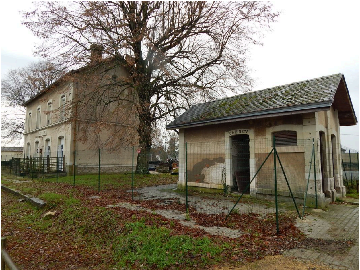
Lampisterie et pignon nord-ouest de la gare.
