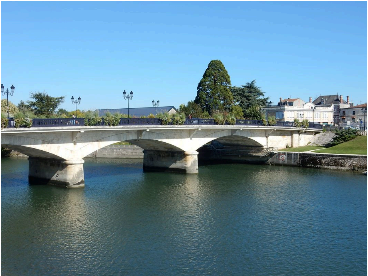
Partie du pont côté rive droite vu de l'amont.
