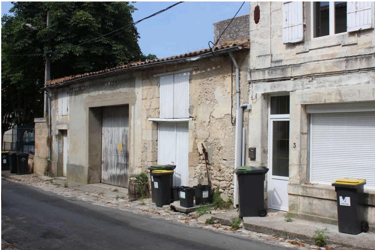
Rue Maurice Gorry : bâtiment de dépendance avec pompe à eau.
