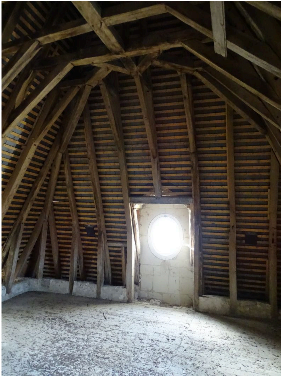
Charpente du pavillon nord-ouest des communs.
