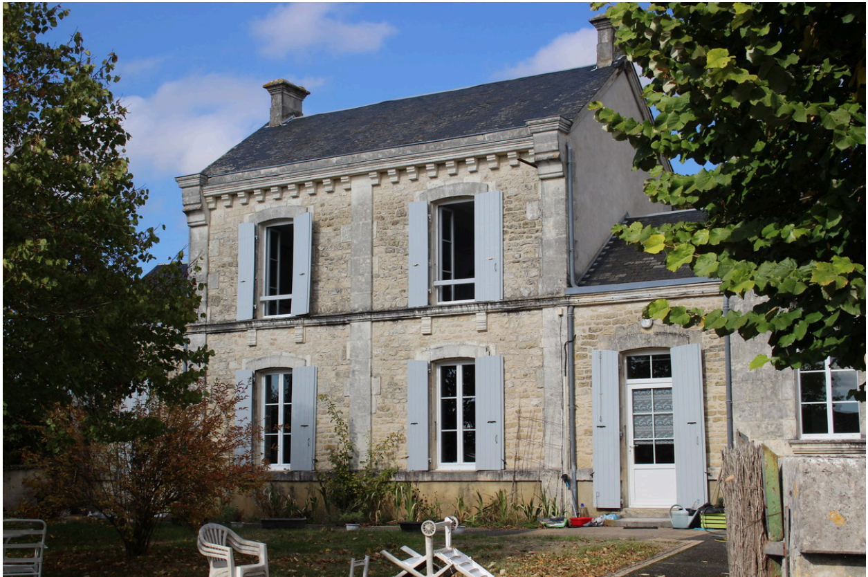
L'ancienne école de Coivert, depuis le sud.
