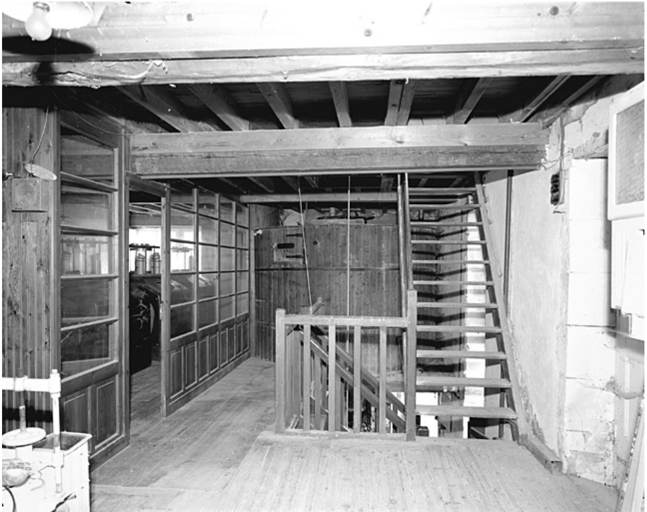
Premier étage de l'atelier de fabrication.
