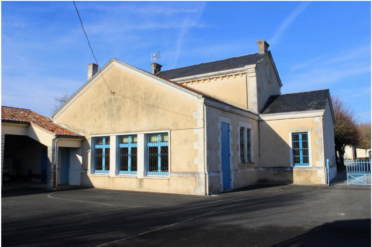
Le corps principal depuis la cour arrière, depuis le sud-est.
