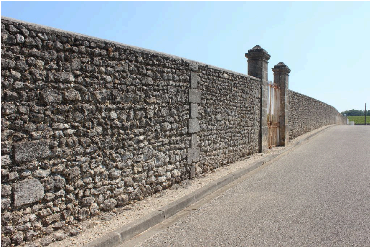
Mur de clôture à l'ouest du château avec portail à piliers maçonnés.
