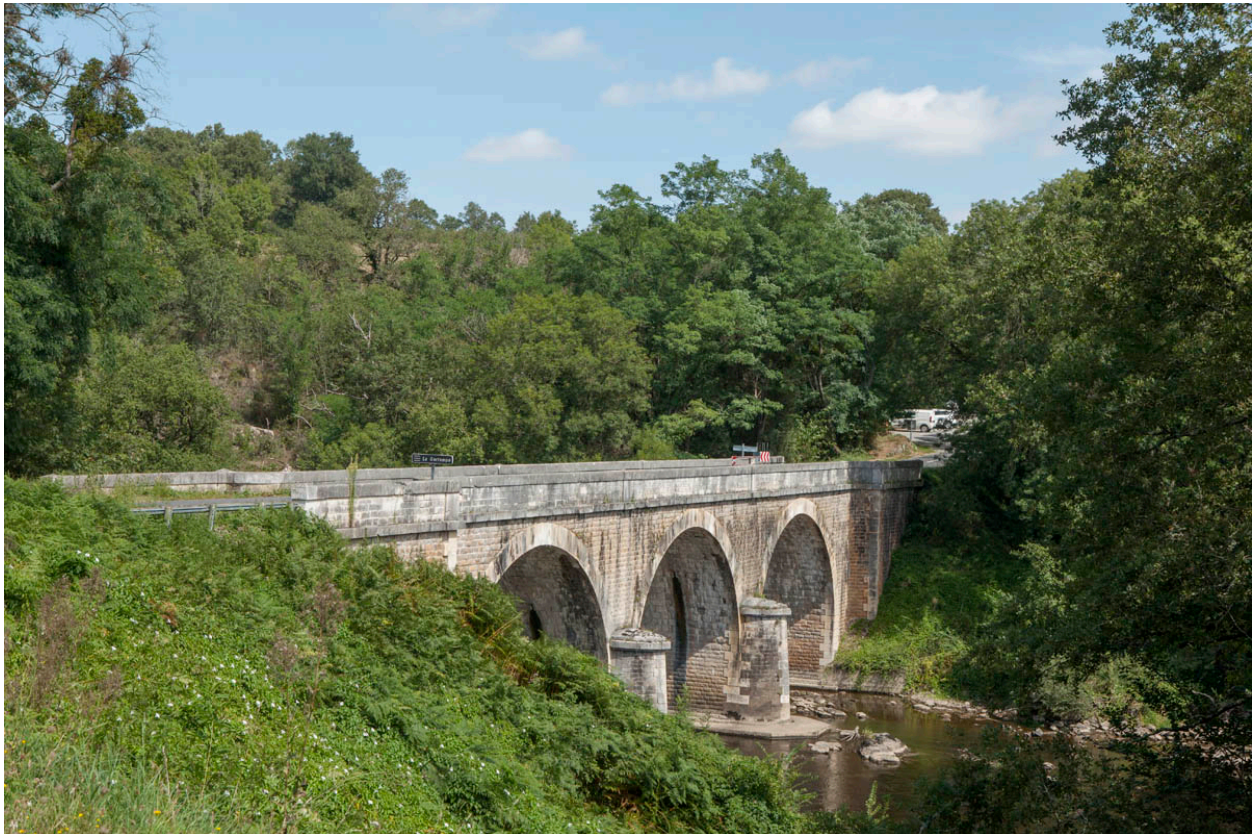
Pont de la RD 10 sur la Gartempe près de Chez-Rageon, commune de Lathus-Saint-Rémy.
