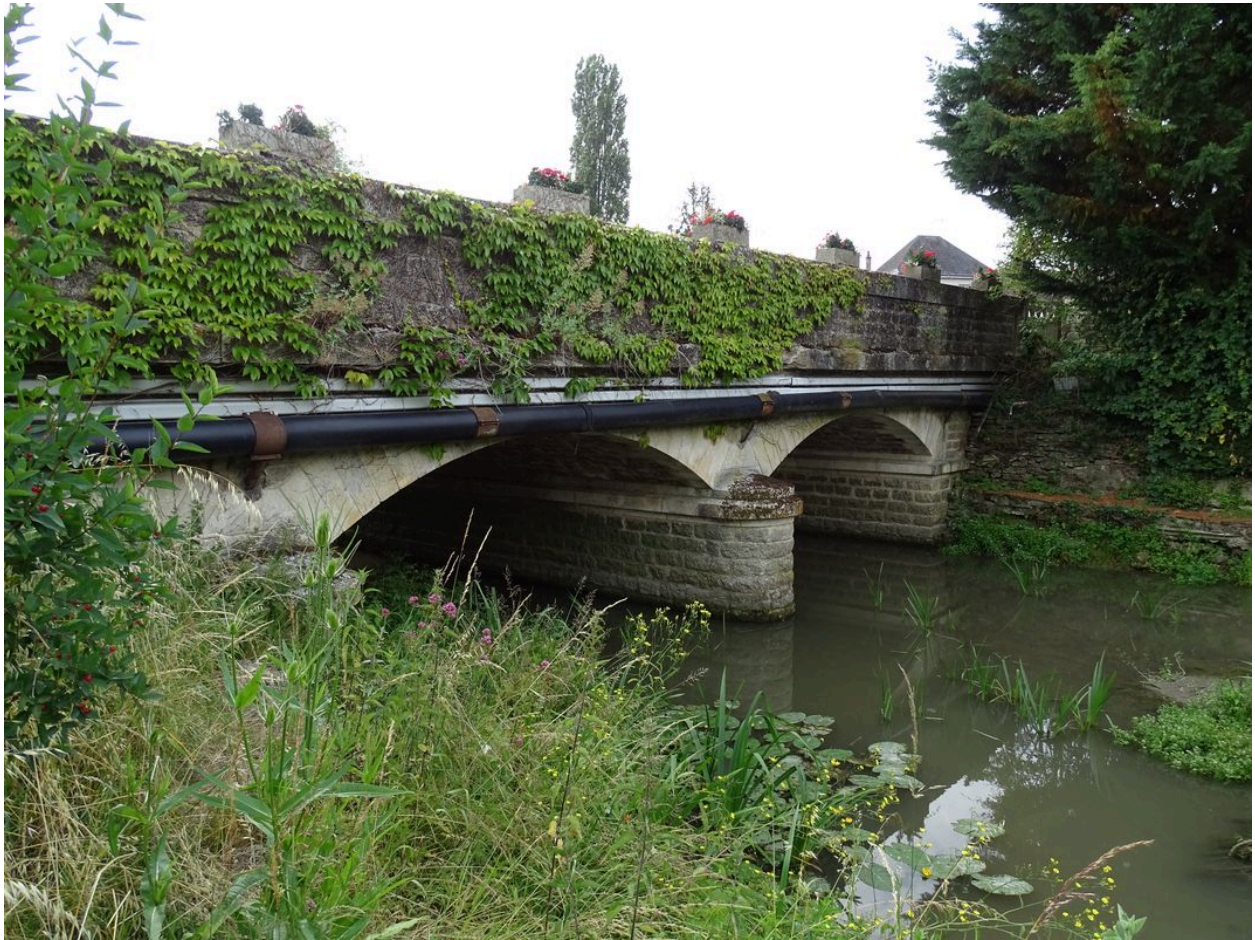
Le pont en amont.
