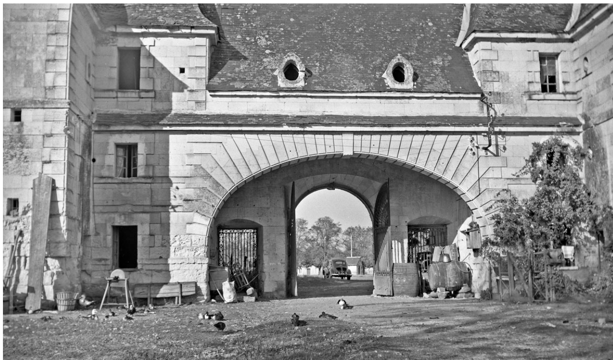
Façade postérieure du porche en anse de panier avec sa porte cochère et ses deux portes piétonnes.
