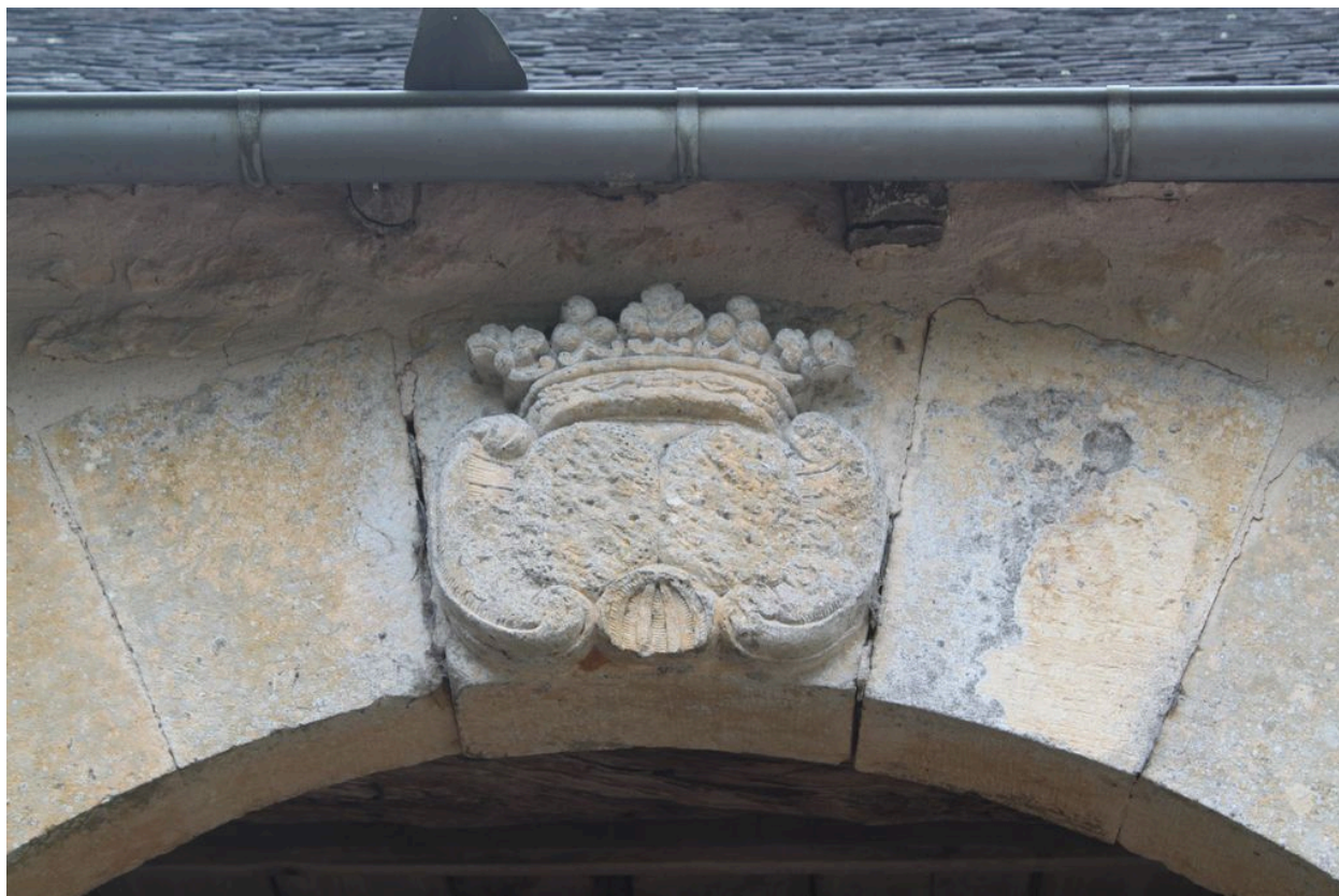
Portail d'entrée, détail : armoiries bûchées.
