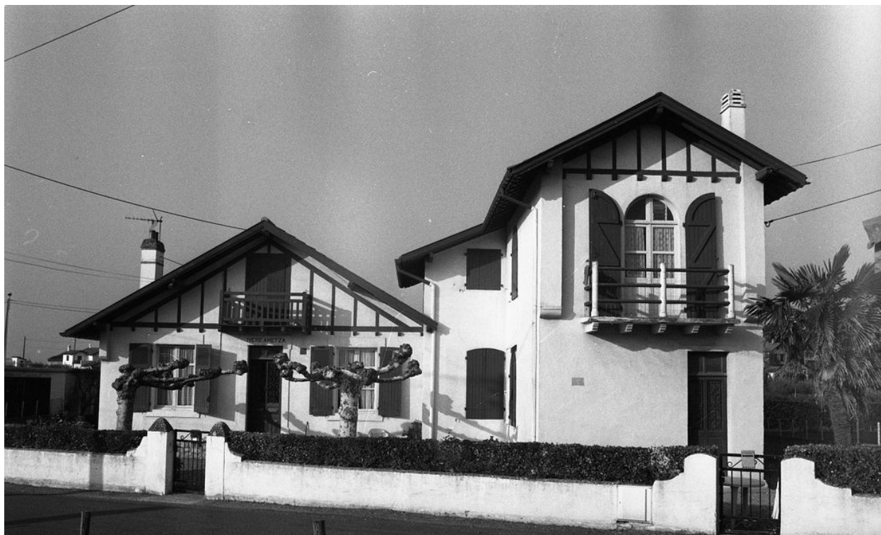
Maison dite villa Nere Ametza, ensemble depuis le sud-est vers 1994.
