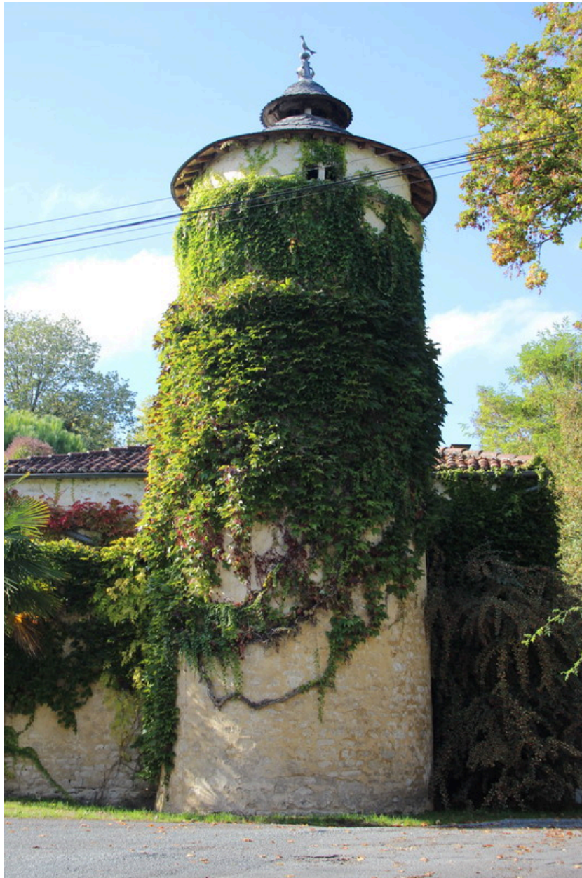
Une vue du pigeonnier, depuis le sud-est.
