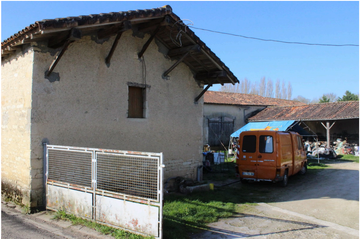
Une vue partielle des dépendances de l'ancienne ferme, depuis le nord-est.
