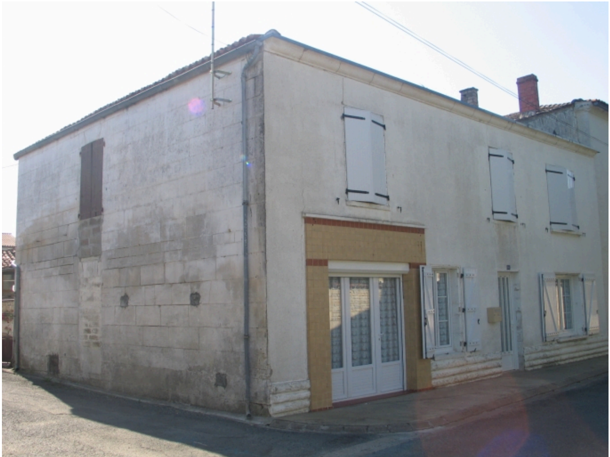
Une vue générale.
