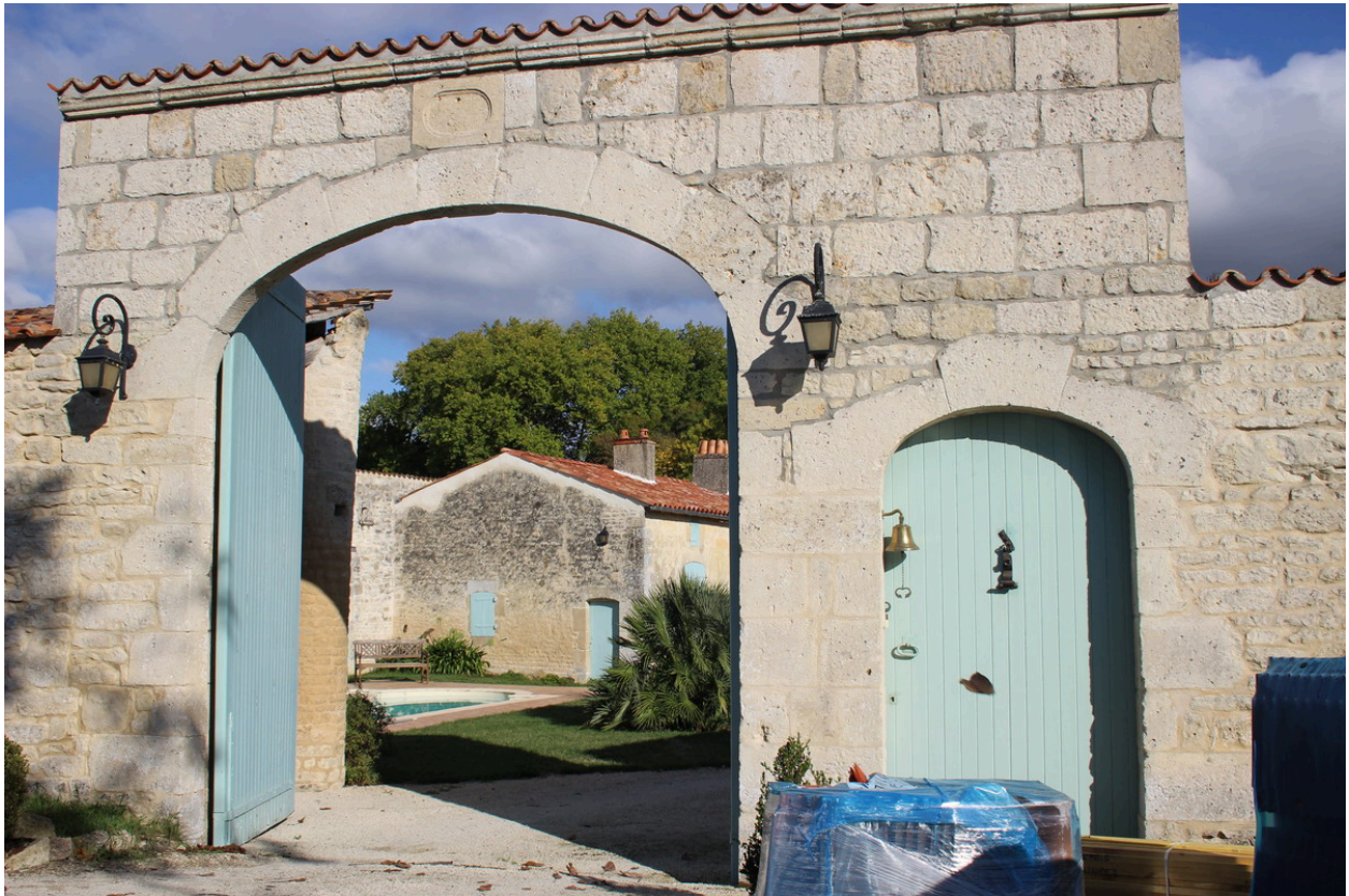
Le portail de l'ancien logis et le premier corps de bâtiments à l'arrière, depuis l'ouest.
