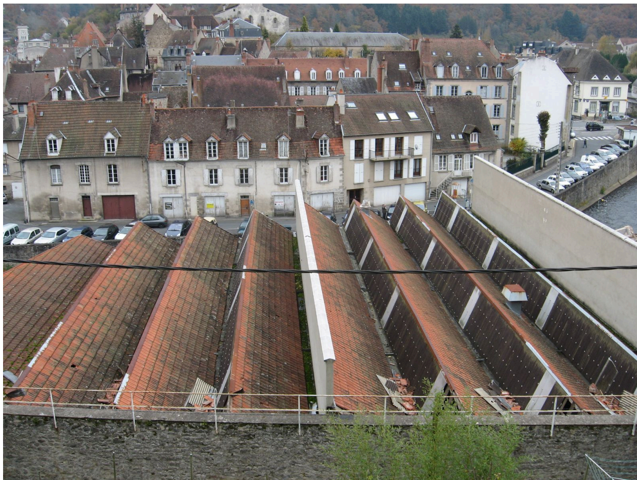
Vue générale des sheds Philips prise depuis le quartier de La Terrade, avant leur destruction complète (novembre 2007).
