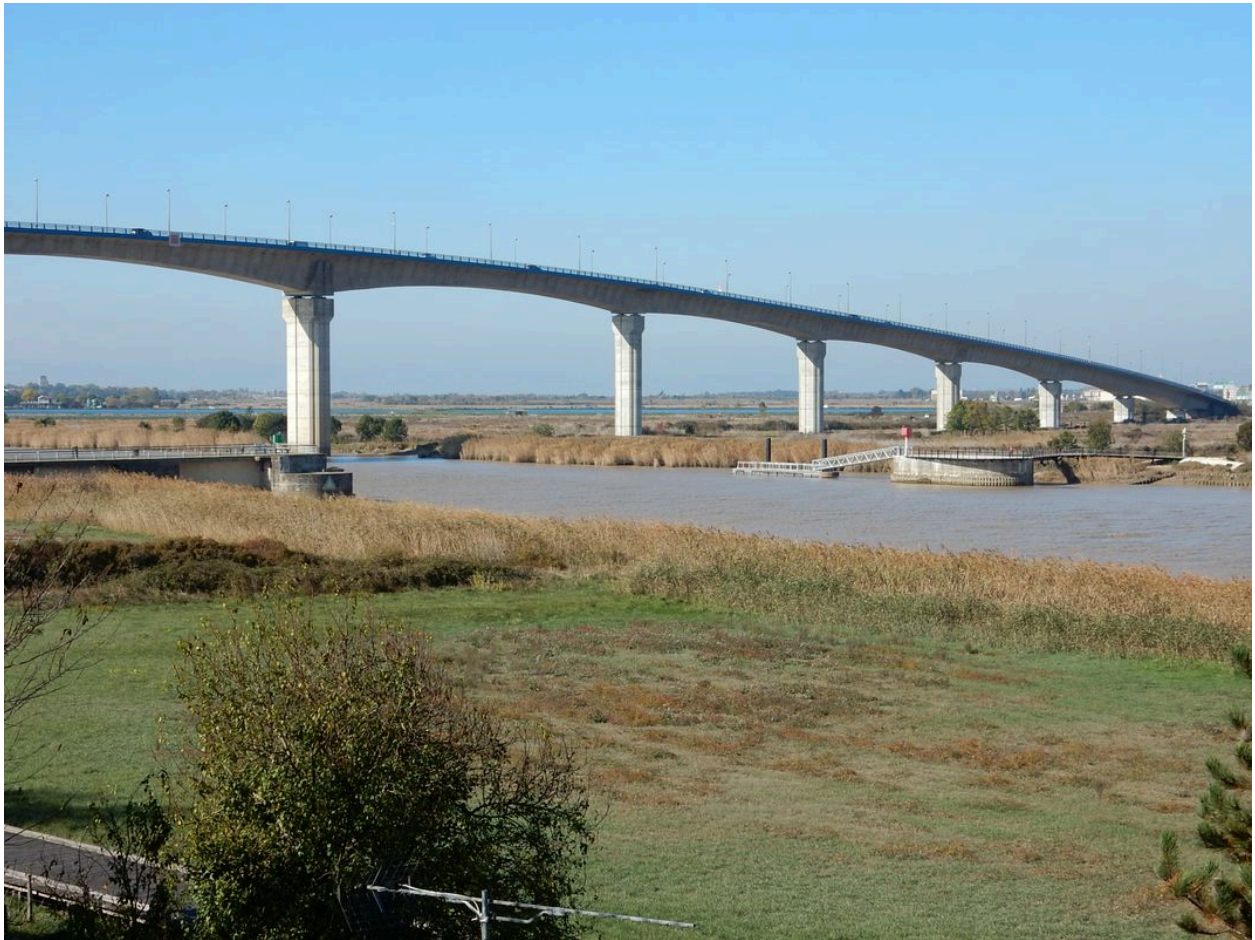
Vestiges des piles du pont avec, à l'arrière-plan, le viaduc.
