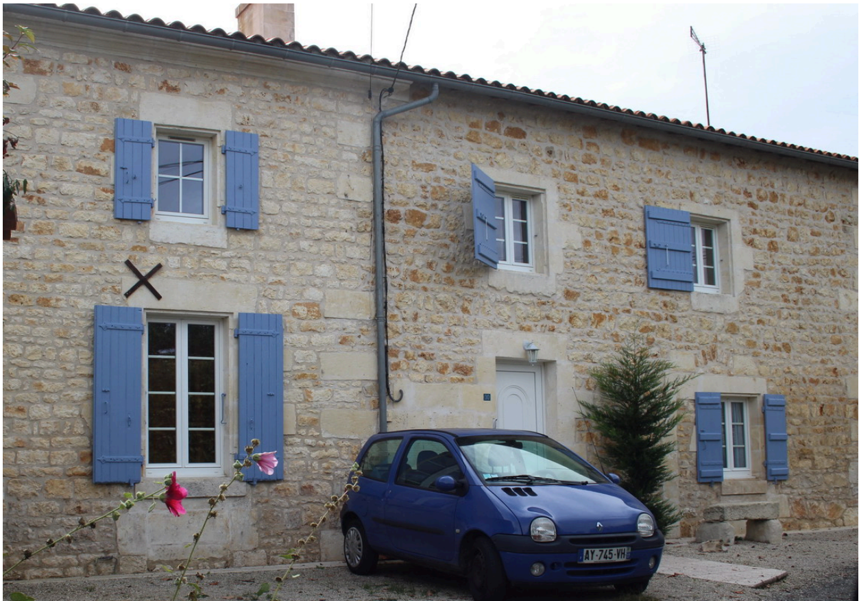
Une vue de la maison, depuis le nord-est.
