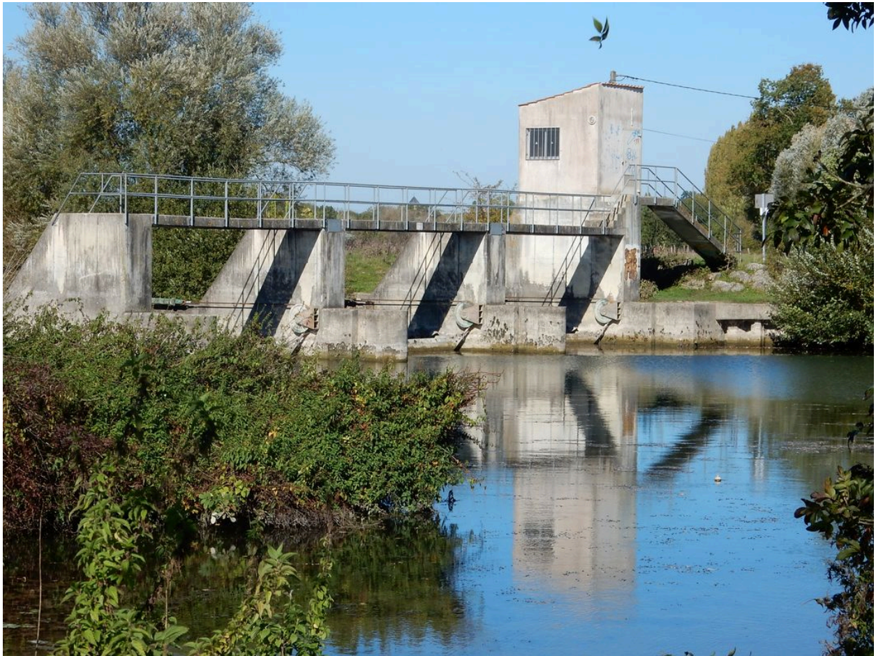
Les vannes vues du sud-est.
