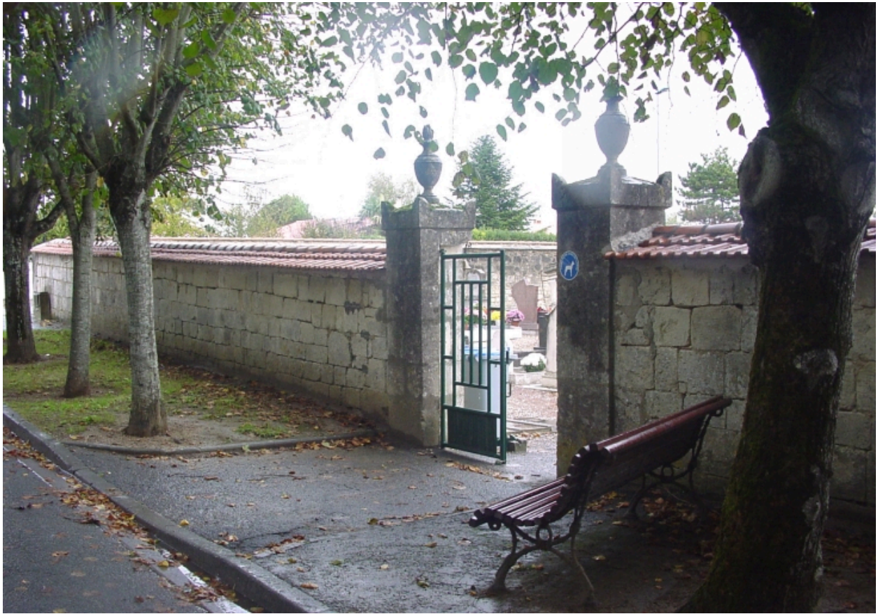
Portail d'entrée et mur de clôture.
