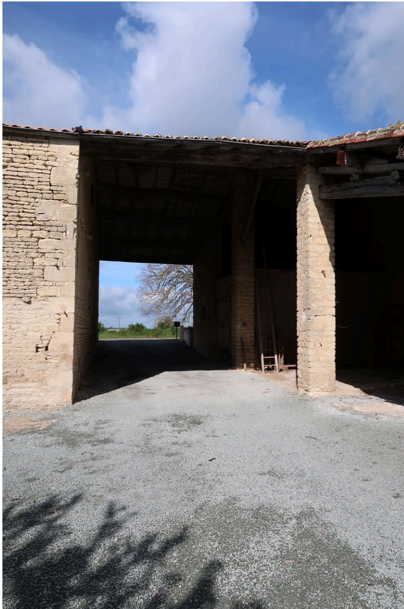
Vue du hangar agricole de la cour vers la Grande rue.
