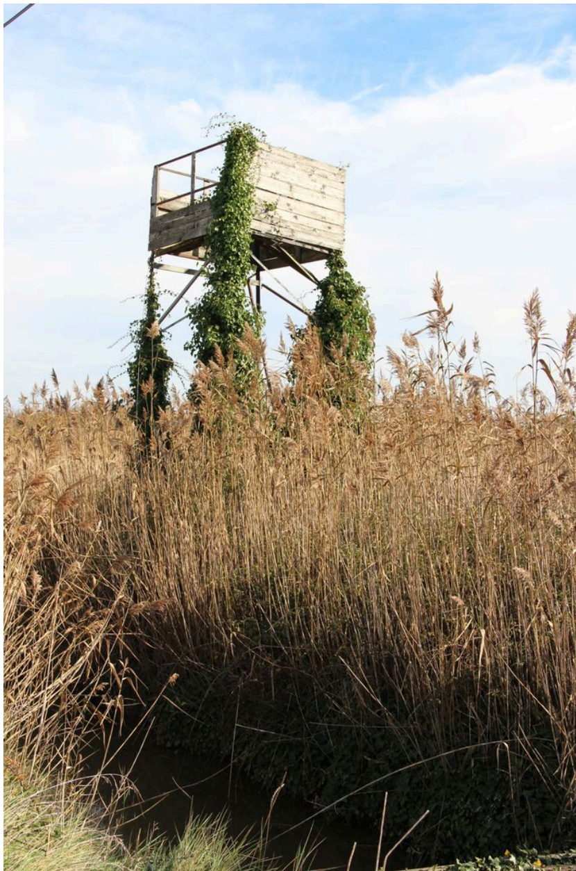
Mattes des Cabireaux : pylône de chasse.
