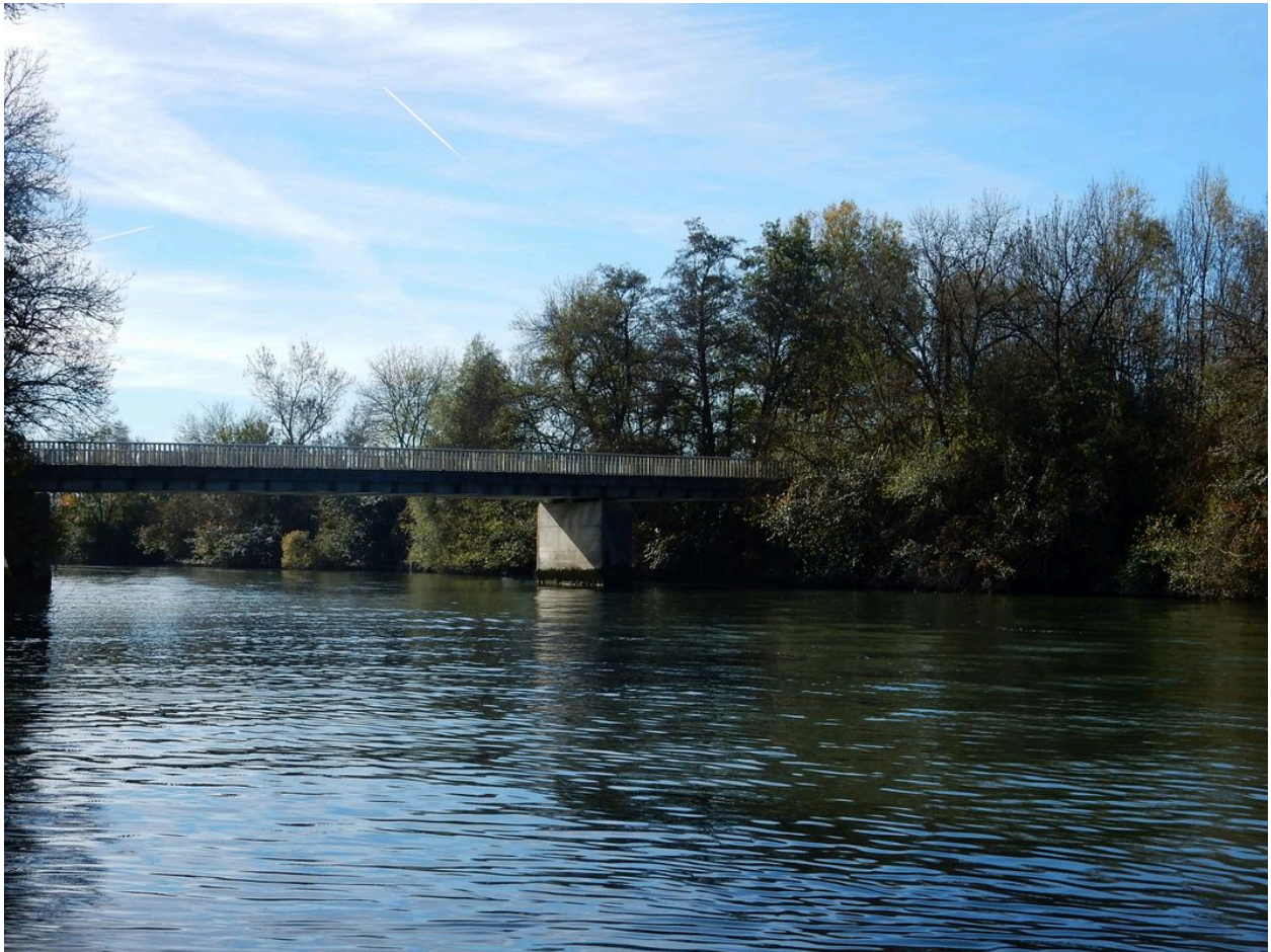
Le pont vu du nord.
