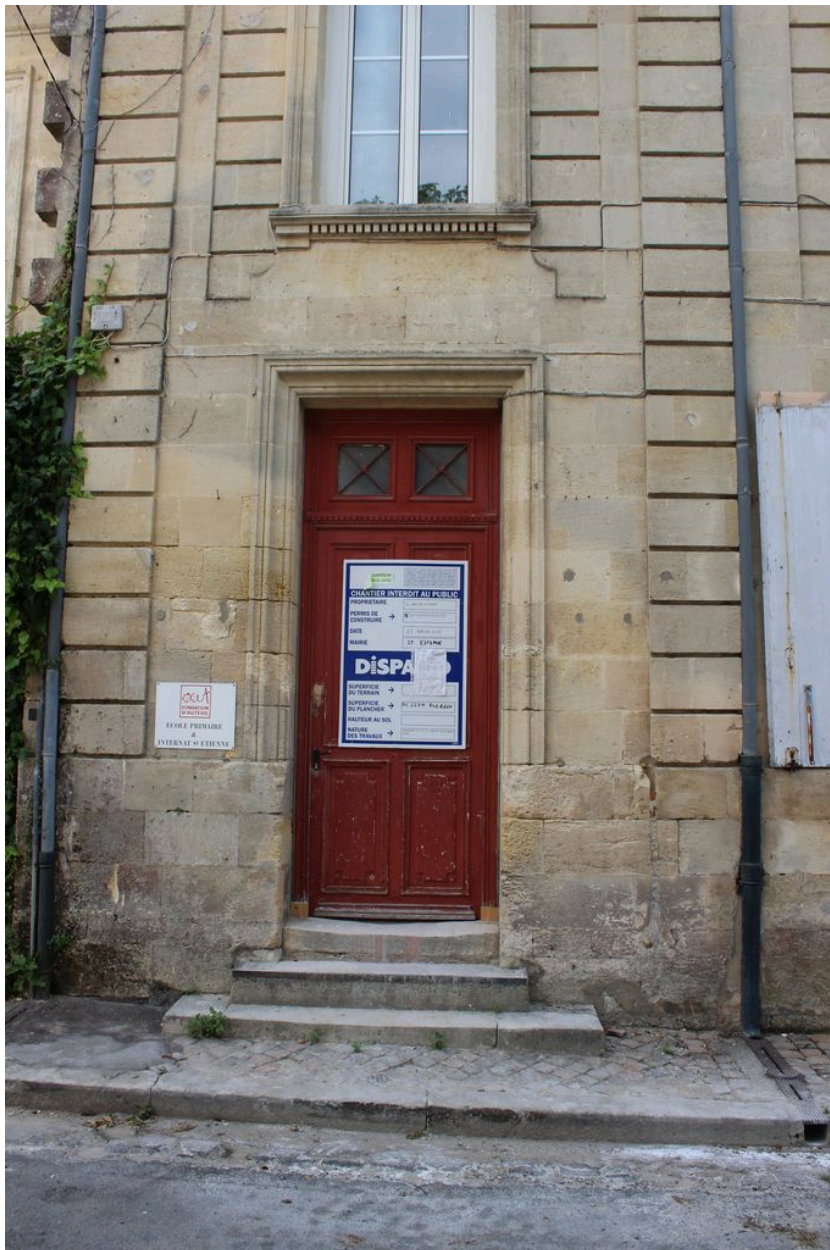
Détail de la porte qui donnait accès à la mairie.
