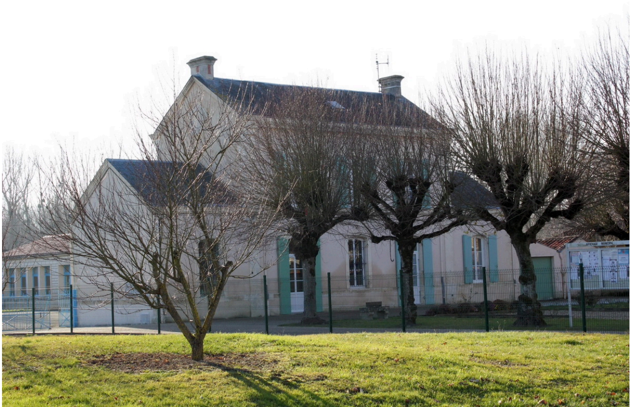
Une vue de l'ancienne école, depuis le nord-est.
