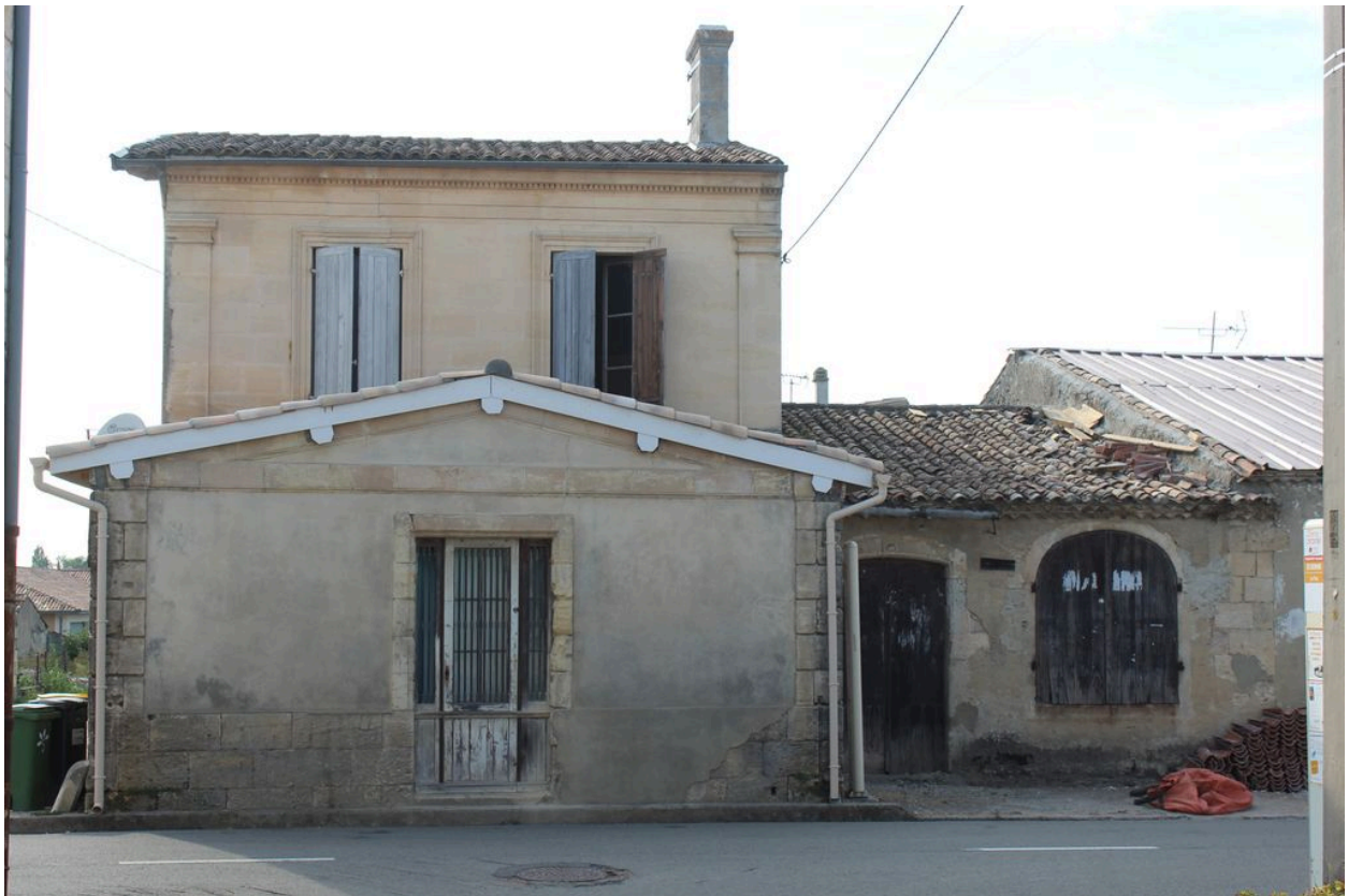
Route des Ormes : maison à étage carré, cuvier avec baie de décharge (parcelles 815, 816).
