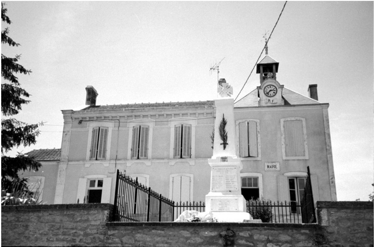
Façade orientée à l'est, rise de vue depuis la rue de la Mairie.
