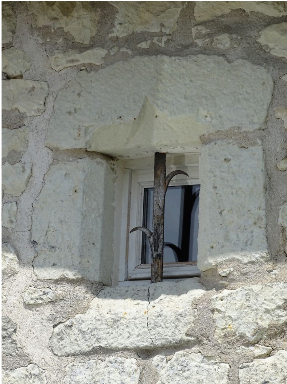
La Chapelle-Soudun : fenêtre surmontée d'un arc en accolade.
