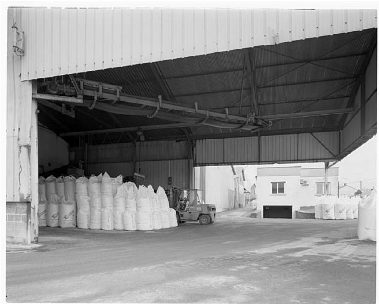
Vue intérieure du bâtiment de stockage en big-bags avec les bureaux en arrière-plan.
