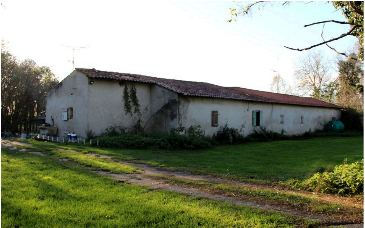
Façade postérieure (nord-est).
