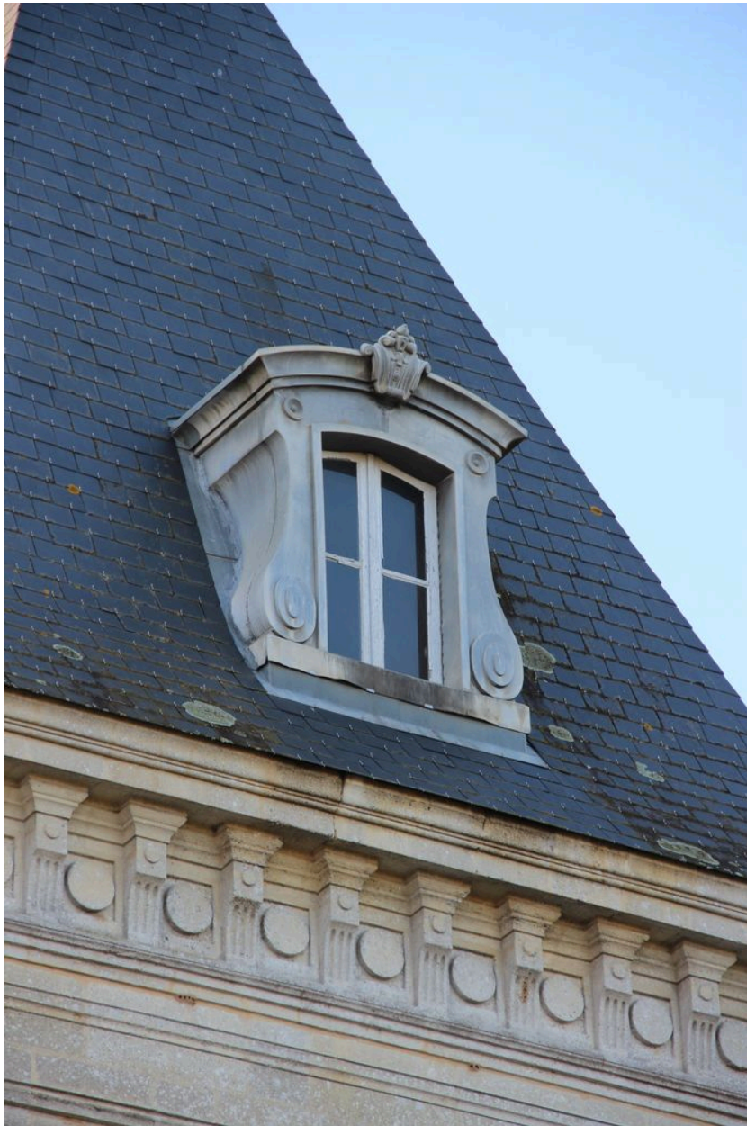
Château : détail du pavillon nord.
