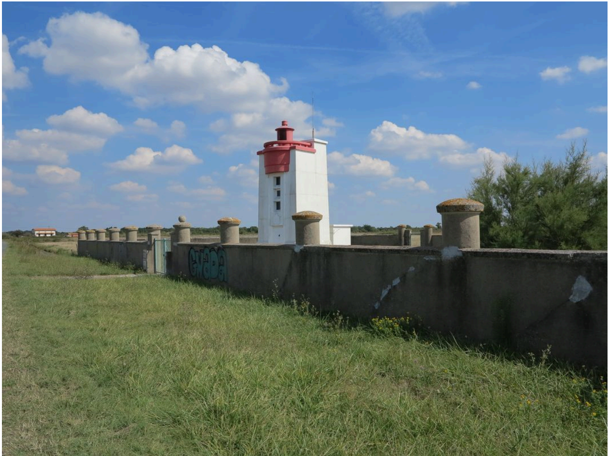
Le feu aval vu du sud-ouest.
